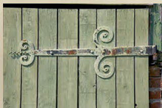
Detail: schmiedeeiserner Beschlag
