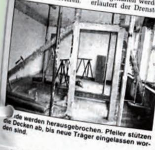
Die Decken werden herausgebrochen, Pfeiler stützen die Decken ab, bis neue Träger eingelassen worden sind.
